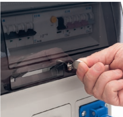
Posibilidad de instalar cerradura metálica Possibility of installing a metal lock
